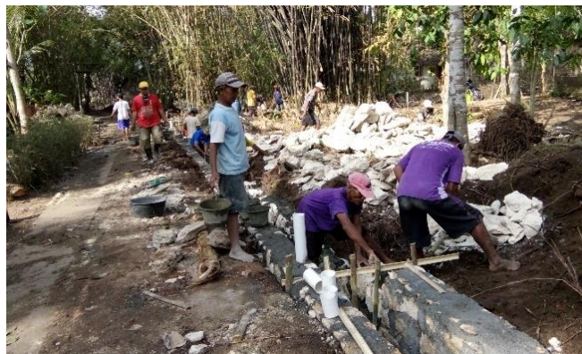
Gambar 4. 14 Kegiatan Padat Karya Infrastruktur Pembuatan Jalan di Dusun Samparan Caturharjo Pandak
