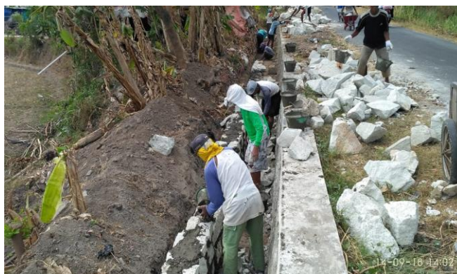
Gambar 4. 16 Kegiatan Padat Karya Infrastruktur Pembuatan Saluran Drainase di Dusun Kepuh Kulon Wirokerten Banguntapan
