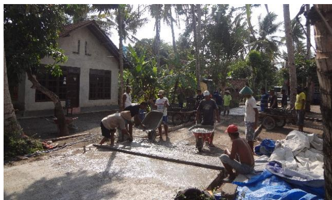
Gambar 4. 15 Kegiatan Padat Karya Infrastruktur Pembuatan Cor Blok Jalan di Dusun Klebakan Kadisoro Gilangharjo Pandak Bantul
